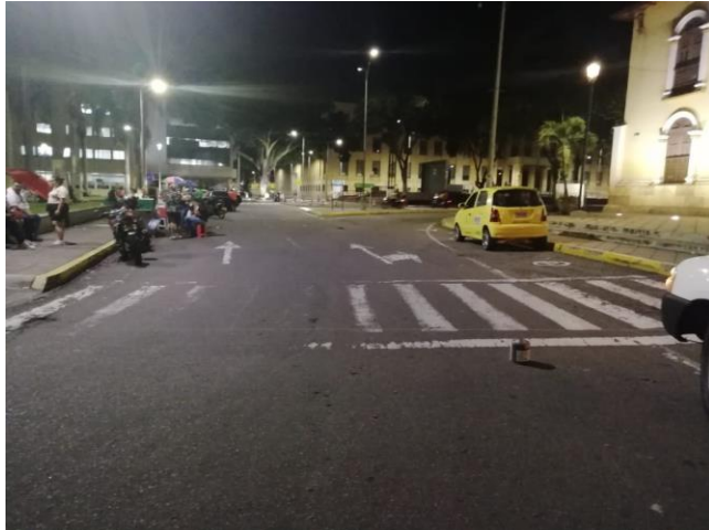
Ubicación: Carrera 11 con Calle 36 Fecha: 23/06/2021 Descripción: Mantenimiento señalización horizontal
