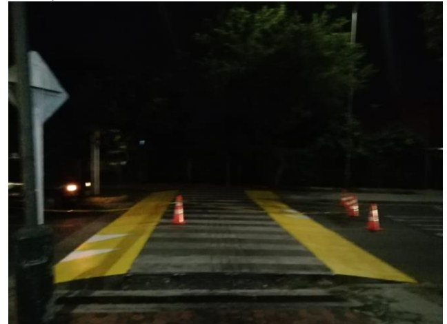
Ubicación: Calle 57 con diagonal 14 - Fecha:11/03/2021 Marsella Real Descripción: Mantenimiento Señalización Horizontal "Resalto Parabólico"
