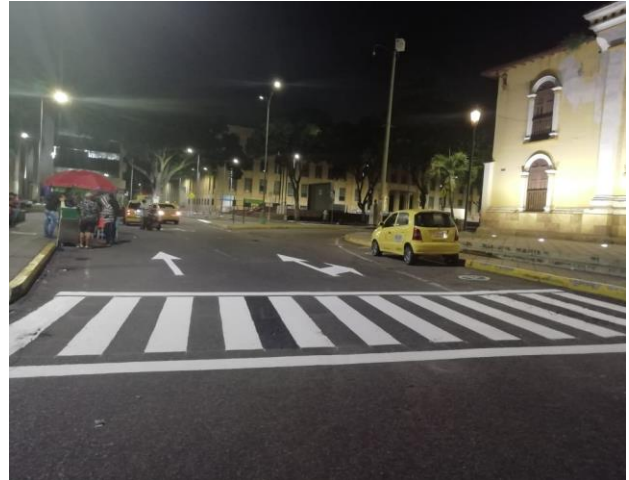
Ubicación: Carrera 11 con Calle 36 Fecha: 23/06/2021 Descripción: Mantenimiento señalización horizontal
