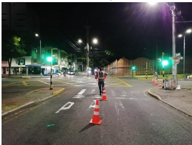
Ubicación: Calle 56 con Carrera 33 Fecha:04/02/2021 Descripción: Mantenimiento Señalización Horizontal "Pare y Línea de pare"
