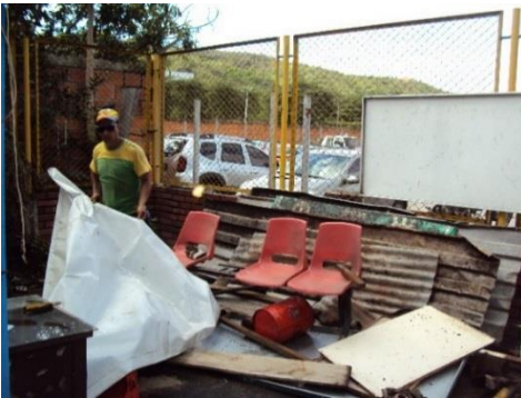
Ilustración 113. Limpieza antigua bomba de TERPEL
