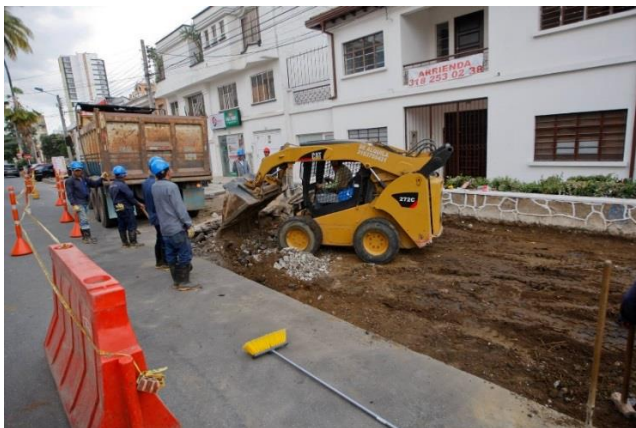
Fotografía 1. Ampliación andén tramo 5 carrera 30 entre calles 32 y 21
