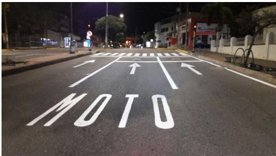
Fotografía 28. Señalización Horizontal Nueva. Carril preferencial para Motocicletas. Fuente: DTB Foto Carrera 27 desde la calle 56 sentido sur – norte
