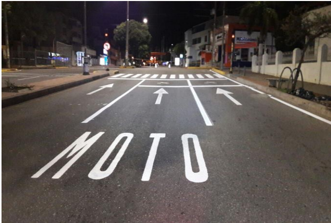
Fuente. DTB Foto Carrera 27 desde la calle 56 sentido sur – norte Carril preferencial para Motocicletas.
