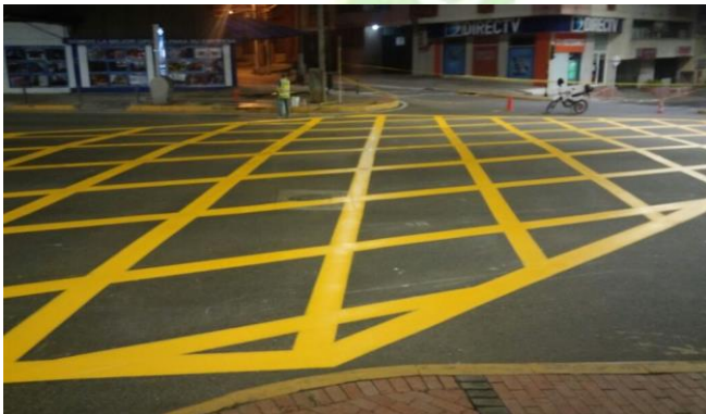
Fuente: DTB Foto Carrera 27 con Av. González Valencia, Señalización Horizontal de Intersecciones.
