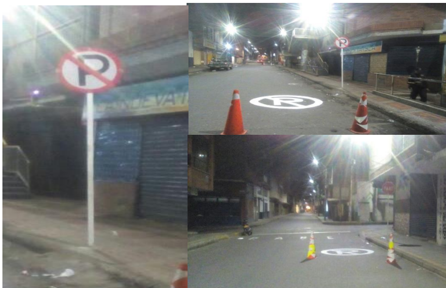
Fotografía: Grupo Planeamiento Vial – Señalización
