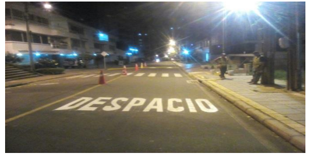
Demarcación de la leyenda DESPACIO en los siete (7) Reductores de Velocidad
