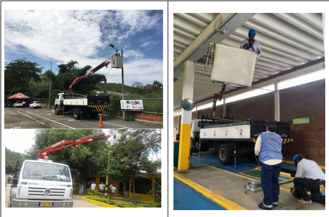
Fotografía 33 Mantenimiento instalaciones del CDA.
