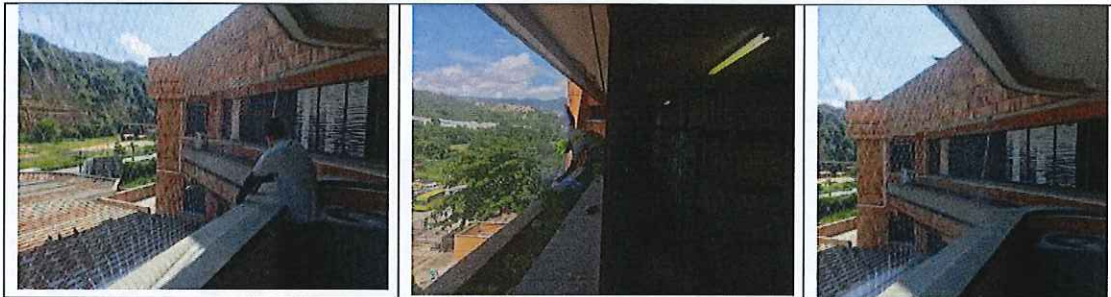
Ilustración 30. Actividades de instalación malla sintética áreas exteriores DTB
