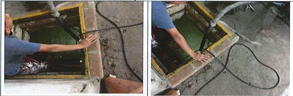
Ilustración 29. Lavado y desinfección de tanques DTB
