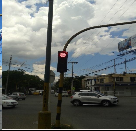
Carrera 27 con Calle 67 se instalaron 6 Semáforos vehiculares (Pedestal) y 04 de ménsula.
