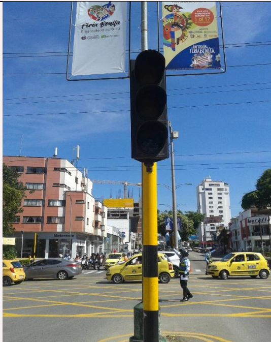
Carrera 27 con Calle 56 se instalaron 06 Semáforos vehiculares (Pedestal) y 02 de ménsula.
