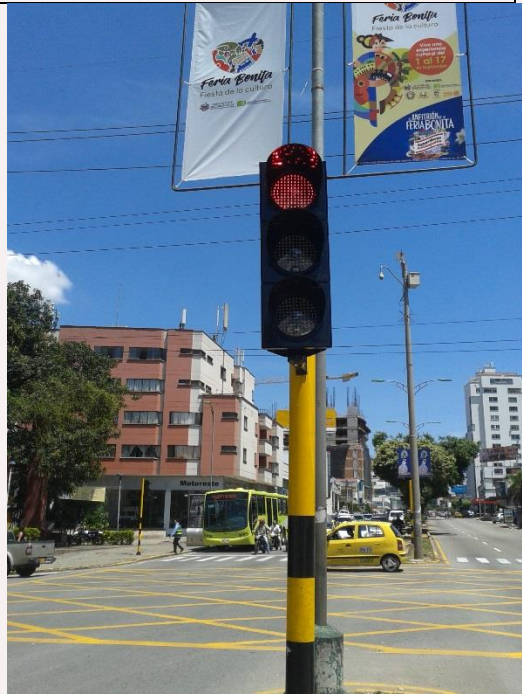
Carrera 27 con Calle 56 se instalaron 06 Semáforos vehiculares (Pedestal) y 02 de ménsula.
