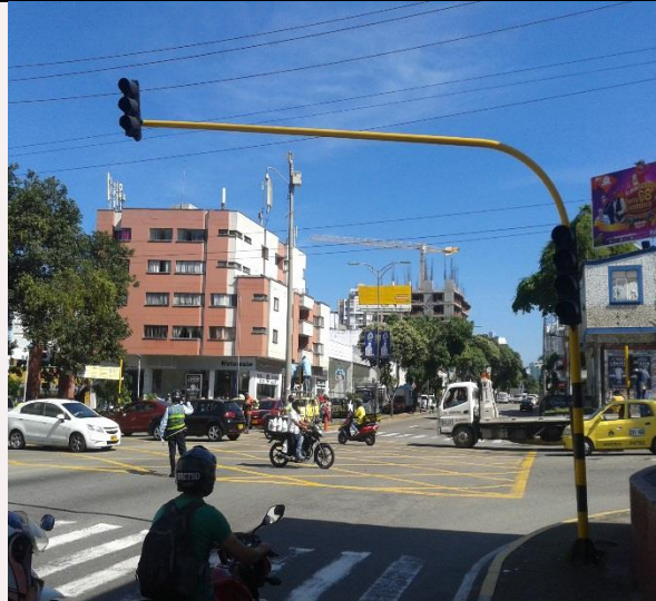
Carrera 27 con Calle 56 se instalaron 06 Semáforos vehiculares (Pedestal) y 02 de ménsula.
