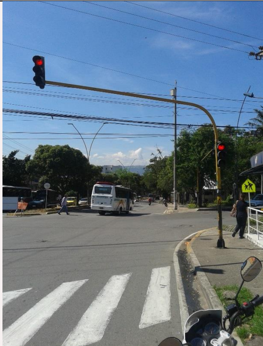
Carrera 27 con Calle 67 se instalaron 6 Semáforos vehiculares (Pedestal) y 04 de ménsula.
