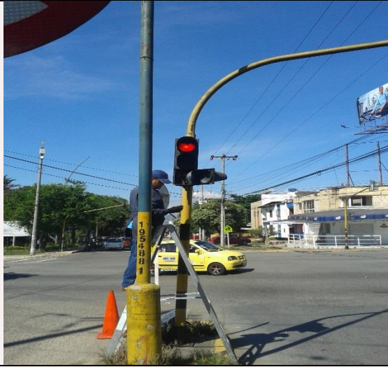
Carrera 27 con Calle 67 se instalaron 6 Semáforos vehiculares (Pedestal) y 04 de ménsula.
