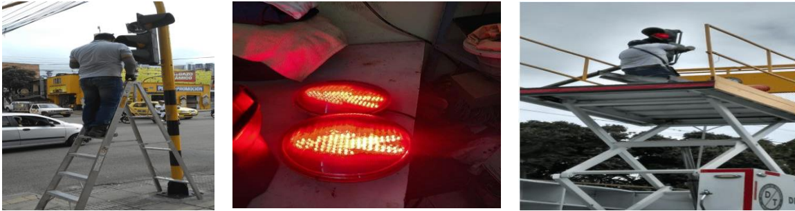
Fotografía 34 Registro fotográfico actividades ejecutadas en semaforización 2020
