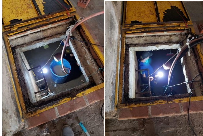
Fotografía 5 Lavado y desinfección de tanques DTB
