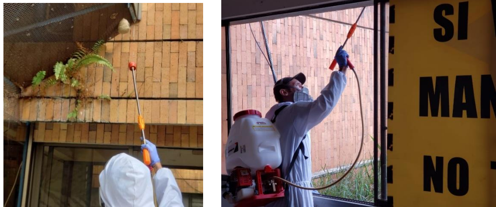
Fotografía 4 Eliminación de Panales
