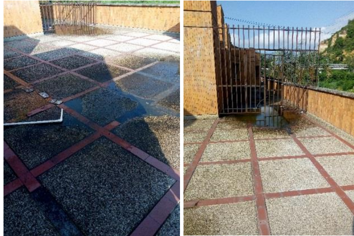
Fotografía 17 Actividades de inspecciones de las terrazas
