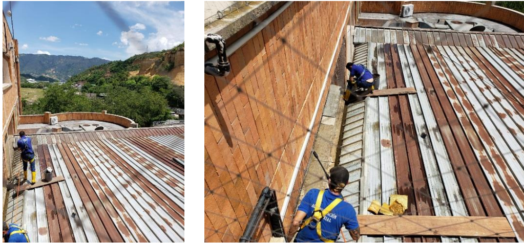
Fotografía 3 Lavado de techo 5 piso sede administrativa
