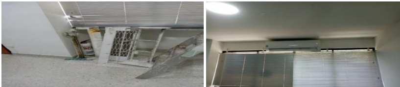
Mantenimiento de aire acondicionado este es la oficina del alado del ofocisina del ing lorenzo (no se el nombre )
