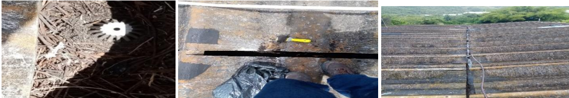
inspección tercera mantenimiento de aire acondicionado adecuación y destaponamiento de canal
