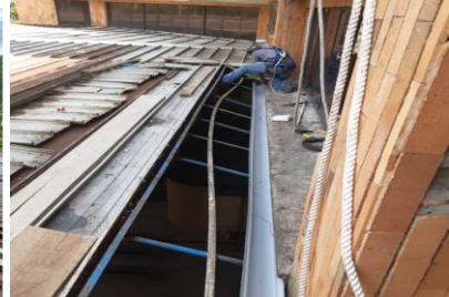
Se ejecuto el contrato N. 346 de fecha 12 de octubre de 2022 el cual tenia como objeto Suministro e instalación de canales techo hall central de la dirección de tránsito de Bucaramanga
