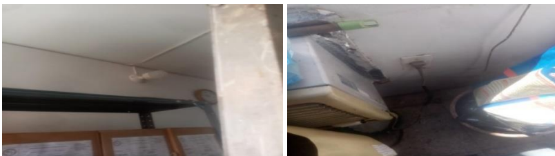
Se desinstala lámpara y se instala un plafón con su respectivo bombillo se arregla una toma que tuvo un cortocircuito y se manipula la caja de tacos para restablecer la corriente
