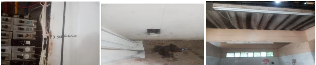
Se desinstala lámpara y se instala un plafón con su respectivo bombillo se arregla una toma que tuvo un cortocircuito y se manipula la caja de tacos para restablecer la corriente
