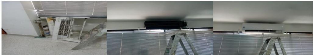
Oficina quinto piso de radio mantenimiento de aire acondicionado limpieza del equipo
