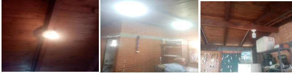
Se hace reparación y fumigación de techo de la garita
