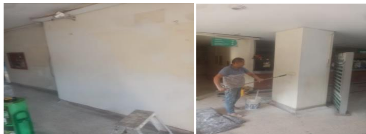
Se hace la instalación de 3 lámparas en la guardia
