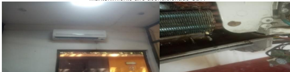
Mantenimiento aire acondicionado oficina de señalización
