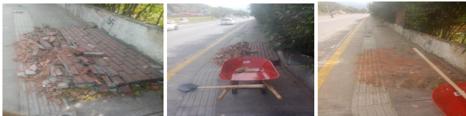
Se hacen trabajos de lijado y pintura de pared del primer piso
