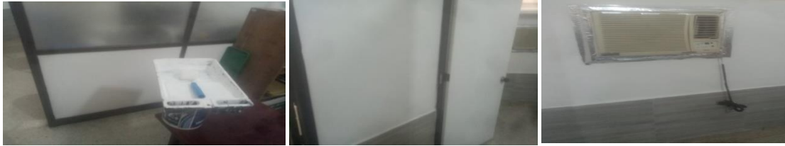
Mantenimiento de aire acondicionado de oficina de contabilidad y Medidas cautelares
