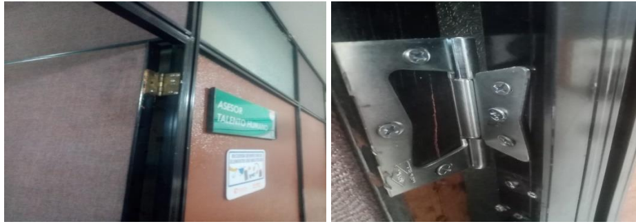
Se desinstala llave vieja y se hace la instalación de una nueva en portería
