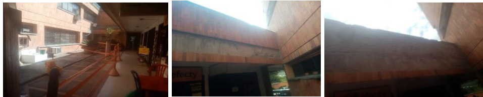
Se hace levantamiento de escombros de concreto de muro de la fachada de la Entidad
