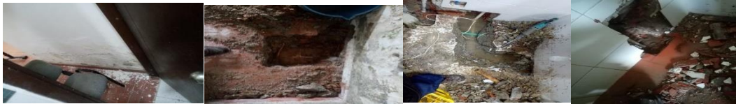
Mantenimiento de aire acondicionado de la oficina equipos y archivos de contratación
