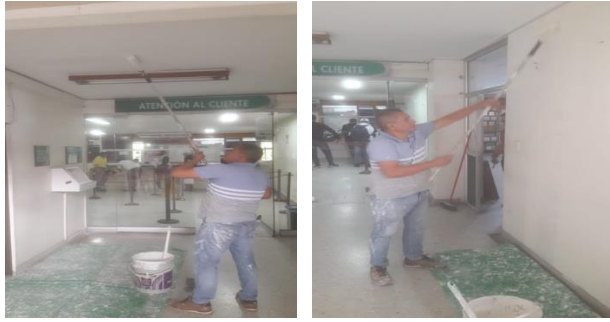
Mantenimiento pintura primer piso atención al cliente
