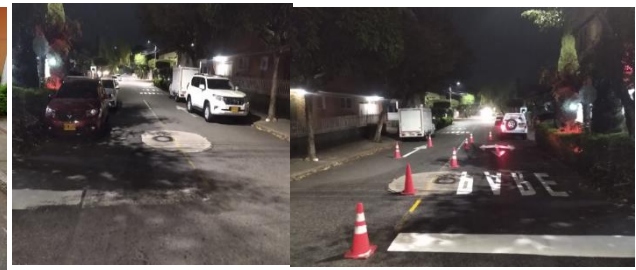
UBICACIÓN: CALLE 89 CON CARRERA 24 DESCRIPCIÓN: LINEA DE PARE, PARE, LINEA DE CARRIL Y FLECHA SENCILLA
