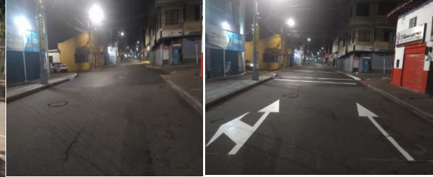
UBICACIÓN: CARRERA 17 CON CALLE 41 DESCRIPCIÓN: SENDERO PEATONAL, FLECHA SENCILLA, FLECHA DOBLE
