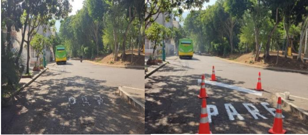
UBICACIÓN: CARRERA 1 CON CALLE 37 DESCRIPCIÓN: LINEA DE PARE, PARE
