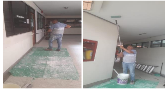
Mantenimiento pintura techo y paredes primer piso inspecciones
