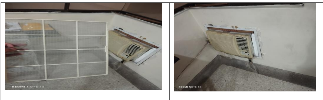
Mantenimiento aire acondicionado de la oficina de señalización 7\11\2023
