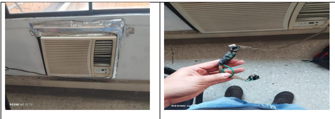
Revisión de aire acondicionado oficina de licencias el cual tenía corto circuito
