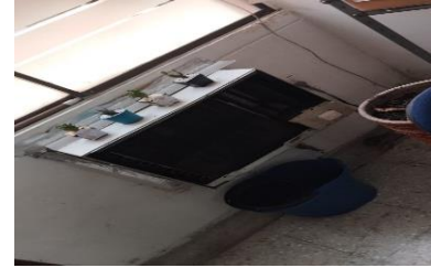
Reparaciones de instalaciones eléctricas en el edificio del CDA
